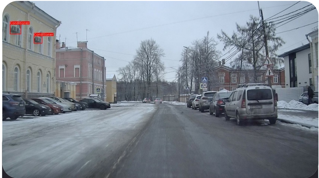
Кондиционер на фасаде здания
